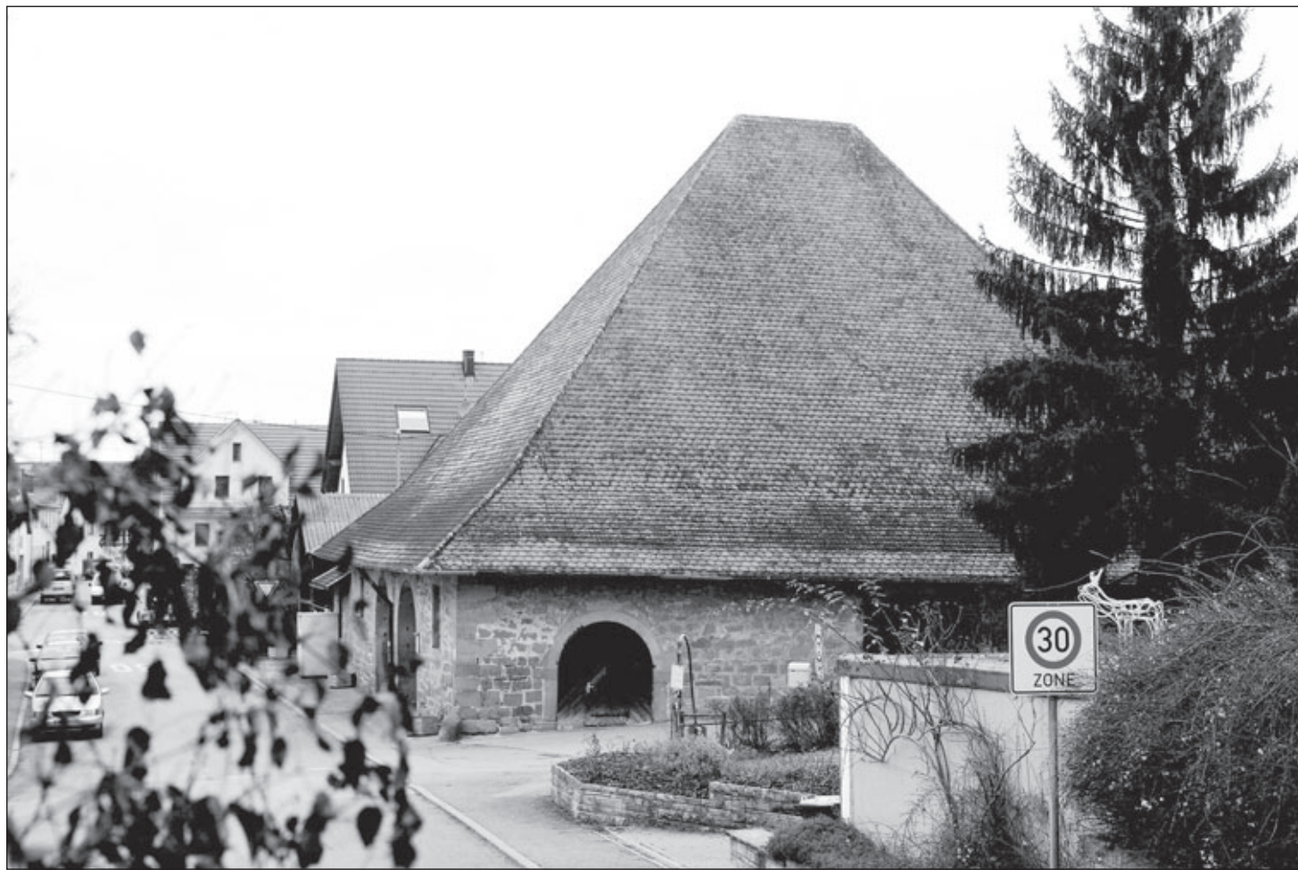
Der Baubeschluss für die Glockenkelter ist gefasst: Kernen wird 1,8 Millionen in die Sanierung stecken.
